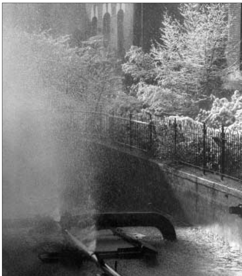
In unmittelbarer Nachbarschaft zum Mollier-Bau passierte es: Die Verbundleitung riss an mehreren Stellen, und Soße spritzte in die freie Natur.
