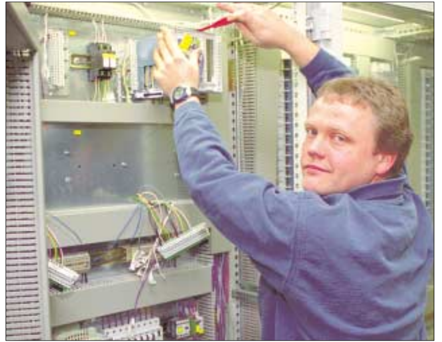
Durch Insolvenz der Elektrofirma wird die neue Zentrale Schaltwarte erst im April fertig. Derzeit wird hier mit Volldampf gearbeitet. Foto (2): UJ/Eckold
