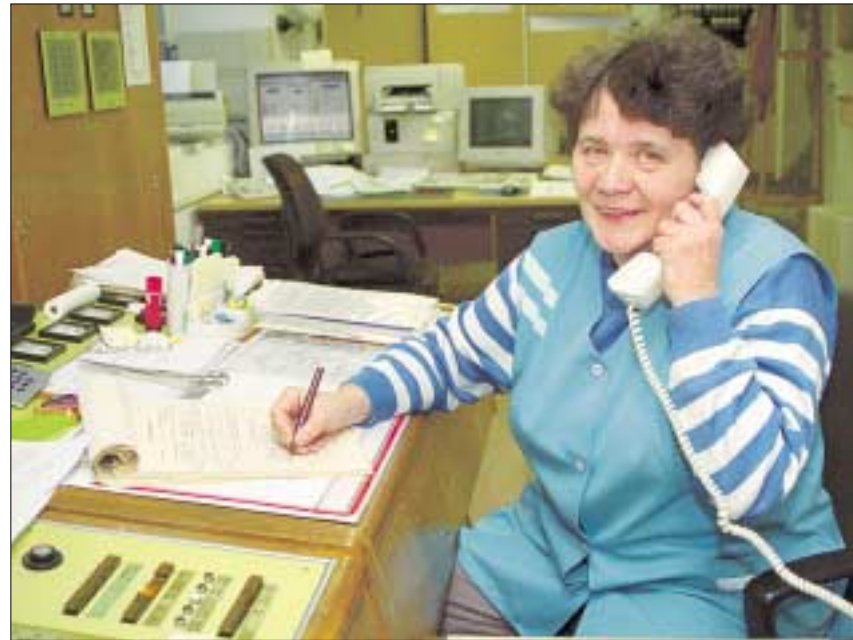
Seit drei Jahren wird die provisorische Schaltwarte betrieben. Für Brigitte Schönbeck (Foto) sowie Irene Illgen und Michael Klemm ein fast musealer Zustand.
