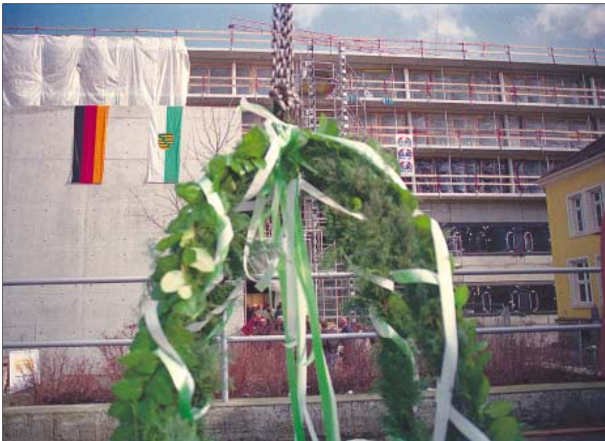
Ende 2002 soll der Neubau fertiggestellt sein und gemeinsam mit dem Operationstrakt das Chirurgische Zentrum des Universitätsklinikums bilden. Am 6. März wurde Richtfest für den 116,6-Millionen-Mark-Bau gefeiert. Auf 10 000 Quadratmetern Nutzfläche werden OP-Säle für die Urologie und die ambulante Chirurgie sowie 28 Intensivpflege- und 150 Normalpflegebetten der Kliniken für Neurochirurgie, Unfall- und Wiederherstellungschirurgie, Urologie und Viszeral-, Thorax- und Gefäßchirurgie untergebracht. Foto: UJ/Eckold
