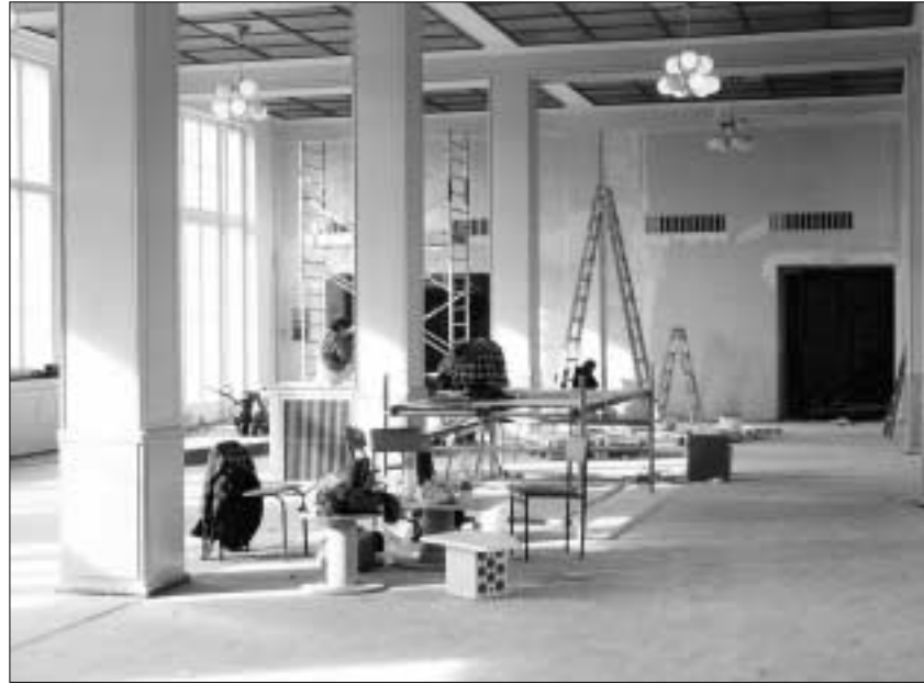
Dieses Foto von den Sanierungsarbeiten im Speisesaal der Mensa ist schon Geschichte. Am 4. April wurde sie frisch saniert wiedereröffnet. Foto: Müller
