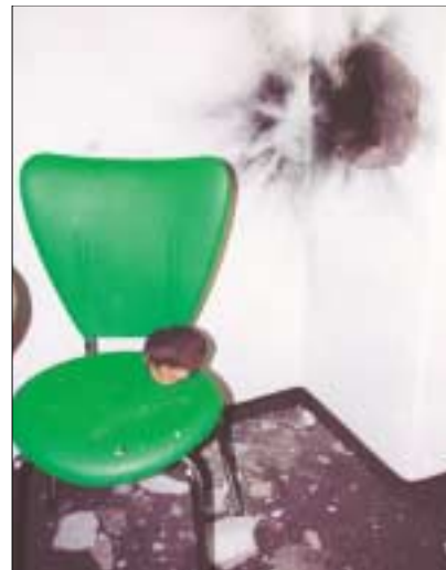
...den Schornstein aufgerissen!
