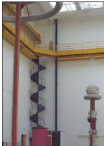
Farbgestaltung der Hochspannungshalle.
