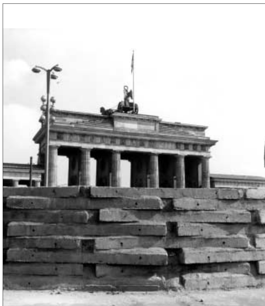
Berlin (W.). Grenzsicherungsanlagen der DDR. Ansicht von Westen gegen das Brandenburger Tor. Aufnahme: Fritz Eschen, 1962; SLUB/DF E 86186
