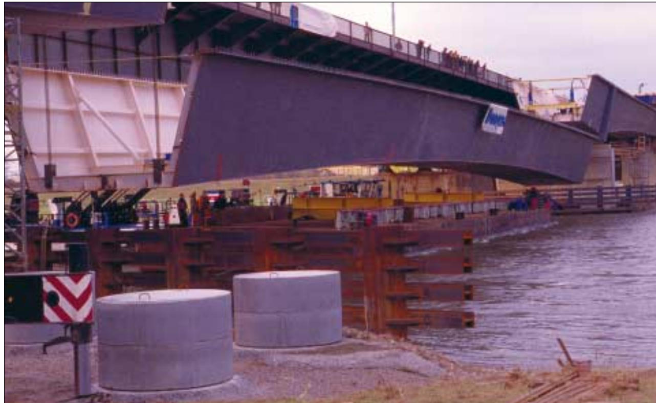
Das Symposium bot umfassende Informationen über den dritzer Elbebrücke. Das Foto zeigt den Hubvorgang des 376 Tonnen schweren Mittelstückes des oberstromseitigen Oberbaues. betrachten Dresdner Bauwerke war der Ersatzneubau der Kaditzer Elbebrücke. Das Foto zeigt den Hubvorgang des 376 Tonnen schweren Mittelstückes des oberstromseitigen Oberbaues. Foto: Stritzke
