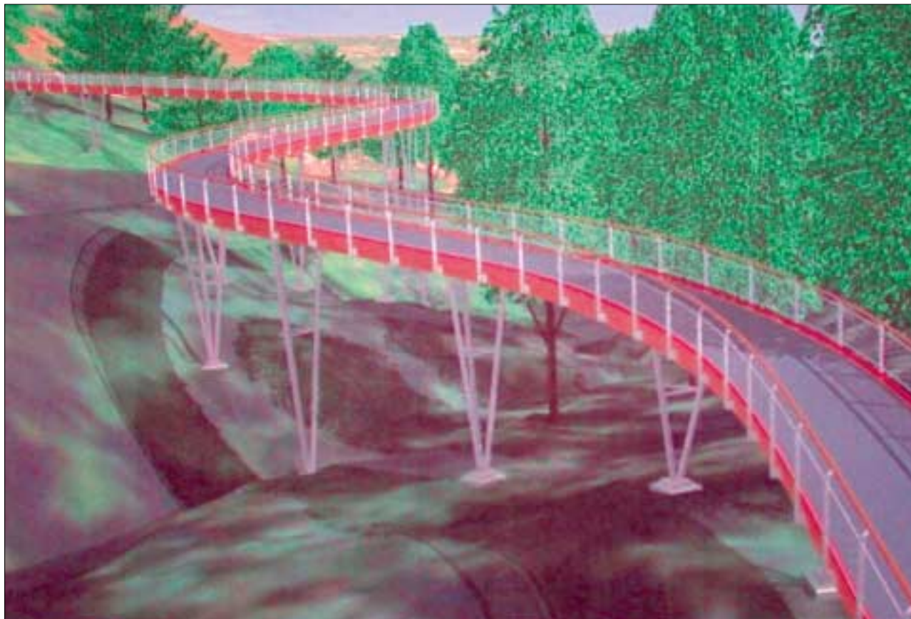
Damit der ForstPark vom Forstbotanischen Garten aus begangen werden kann, muss eine Brücke über die stark befahrene und deshalb gefährliche Freiburger Straße gebaut werden. Der Weg über die Brücke wird auf ihrer gesamten Länge leicht ansteigen und sich durch die Baumkronen der angrenzenden Gehölze schlängeln.
