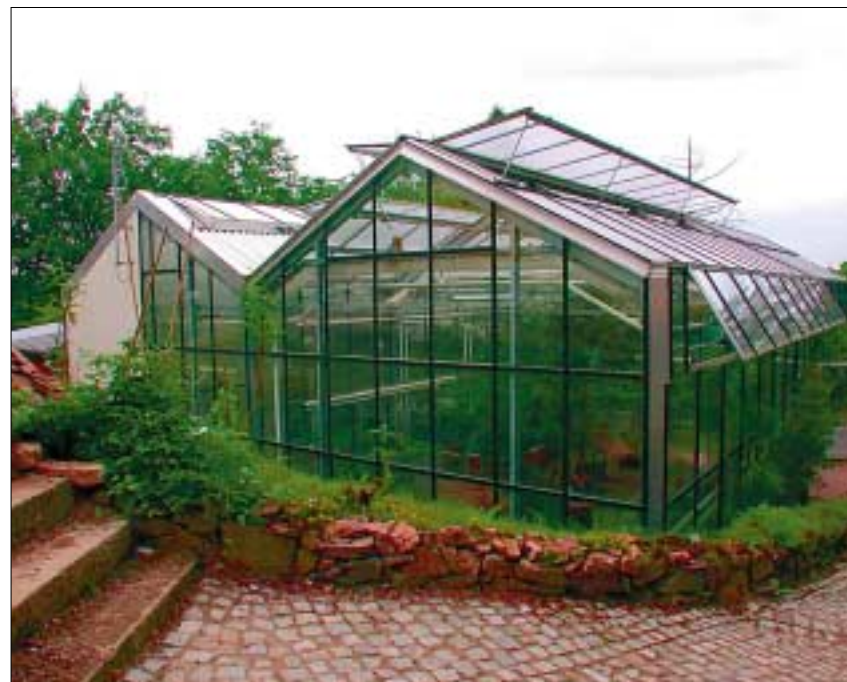
Auch das neuere, 1997/98 erbaute Gewächshaus ist natürlich beheizbar; es gliedert sich in vier Abteilungen.
