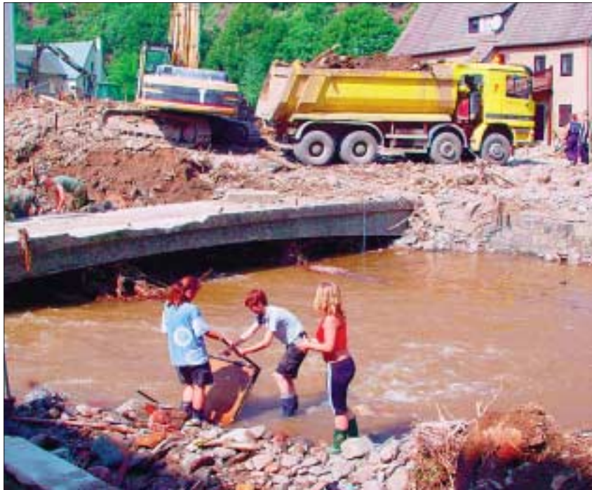
Nach der Flut in Tharandt: Drei Studentinnen reinigen einen Tisch aus dem Cotta-Bau in der Weißeritz, während Schutt abtransportiert wird. Foto: UJ/Eckold
