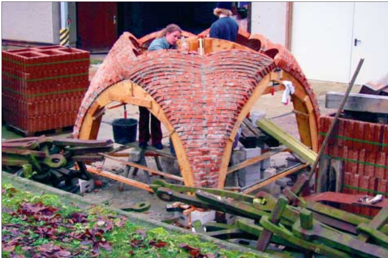
Das Modellieren eines Gewölbes »aus freier Hand«, hier das der Kirche von Boitin / Mecklenburg, gehört zu den praktischen Übungen der Studenten an der Professur für Tragwerksplanung. Das Projekt ist in die laufende Forschung eingebunden, das fertiggestellte Gewölbe wird für Tests von innovativen Reparaturverfahren genutzt. Foto: David Wendland
