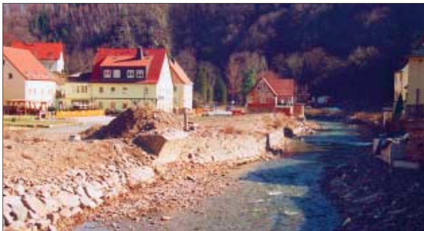
Eine neue Sandsteinbrücke – hier im Bild die traurigen Reste der alten – soll die Ortsteile bald wieder miteinander verbinden.
