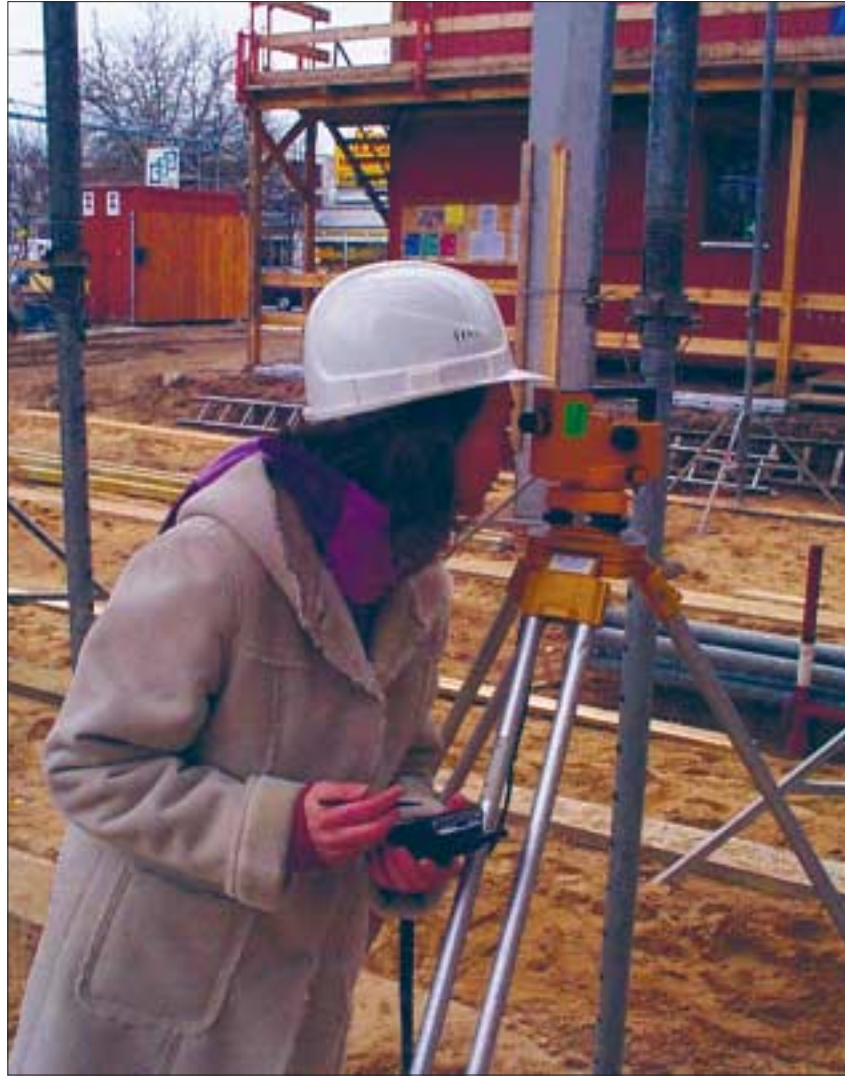
Mit dem luK-System Bau können Mängel sofort dokumentiert und damit effizienter und mit weniger juristischem »Sprengstoff« gemangelt werden. Foto: luK
