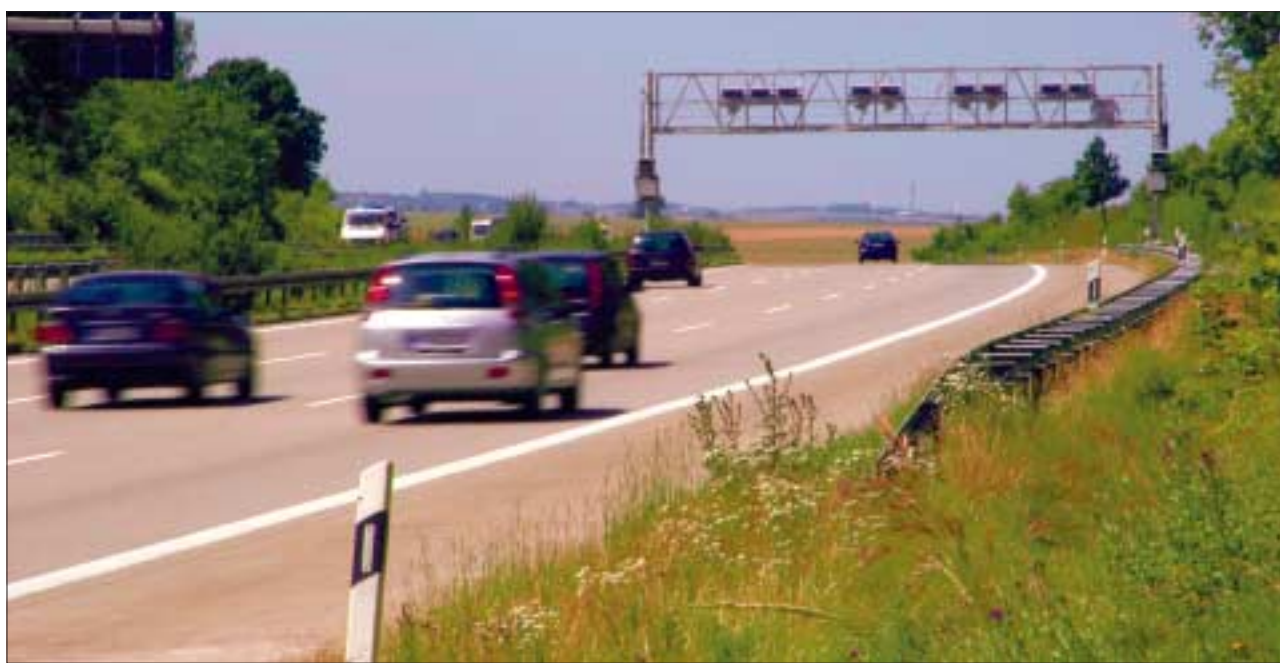
Auf deutschen Autobahnen zeugen derzeit lediglich die bereits errichteten Mautbrücken, hier jene bei Wilsdruff, davon, dass die satellitengestützte Mauterfassung eingeführt wird. Wann, das steht direkt neben den Satelliten – in den Sternen. Foto: UJ/Geise
