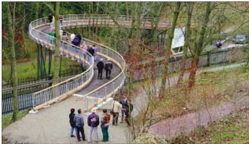
Mit Schwung über den Zeisiggrund: ausgezeichnete Brücke. Foto: UJ/Geise
