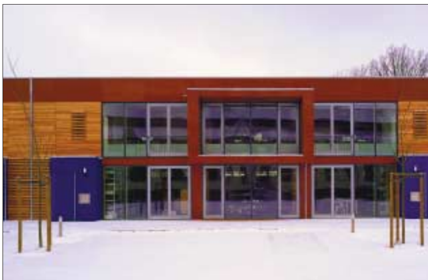
Südseite des Atelierhauses in Dresden-Hellerau.
