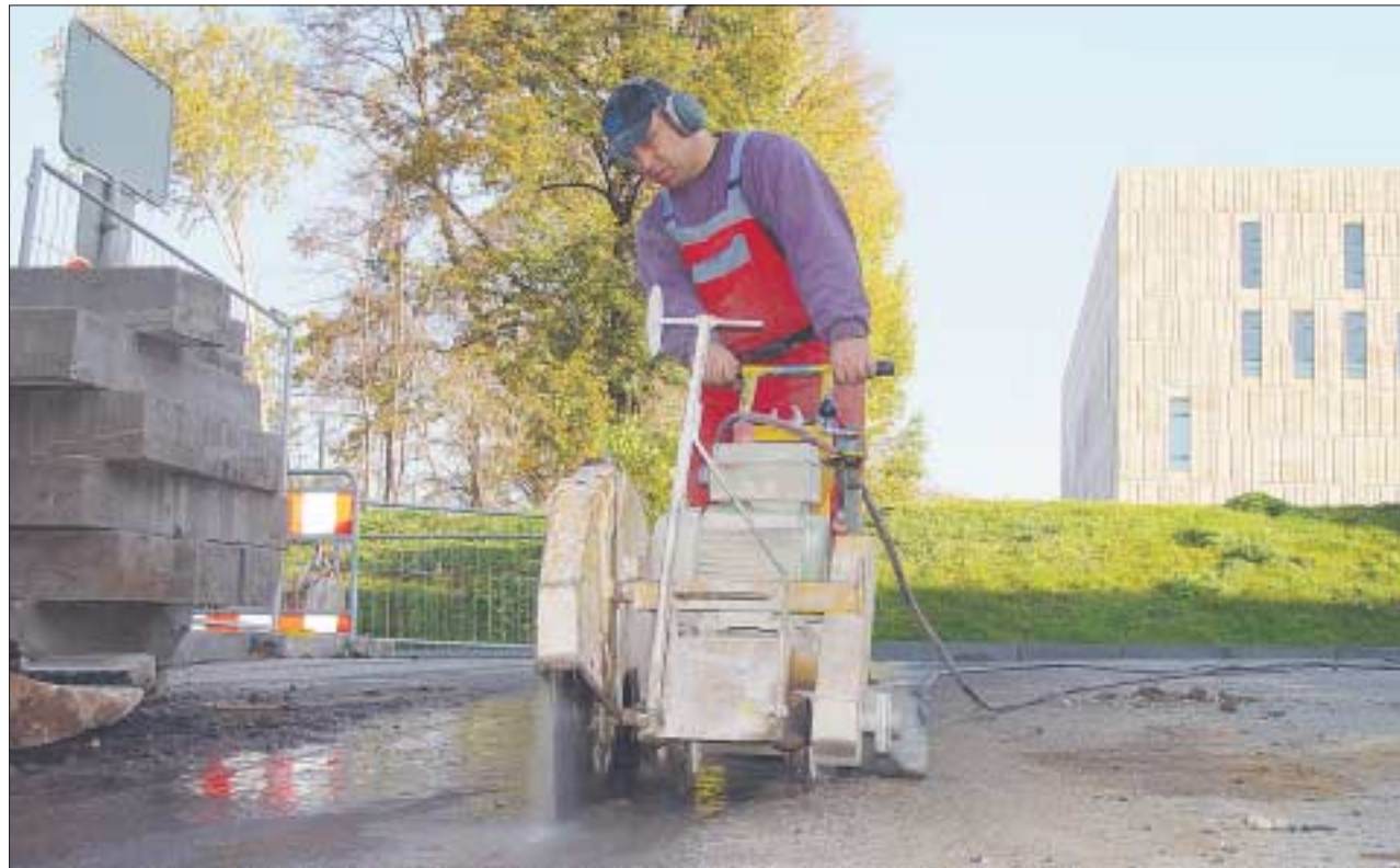
Sägen für die Wissenschaft: Derzeit laufen die Arbeiten für den Trefftz-Anbau auf lautstarken Hochtouren. Foto: UJ/Eckold
