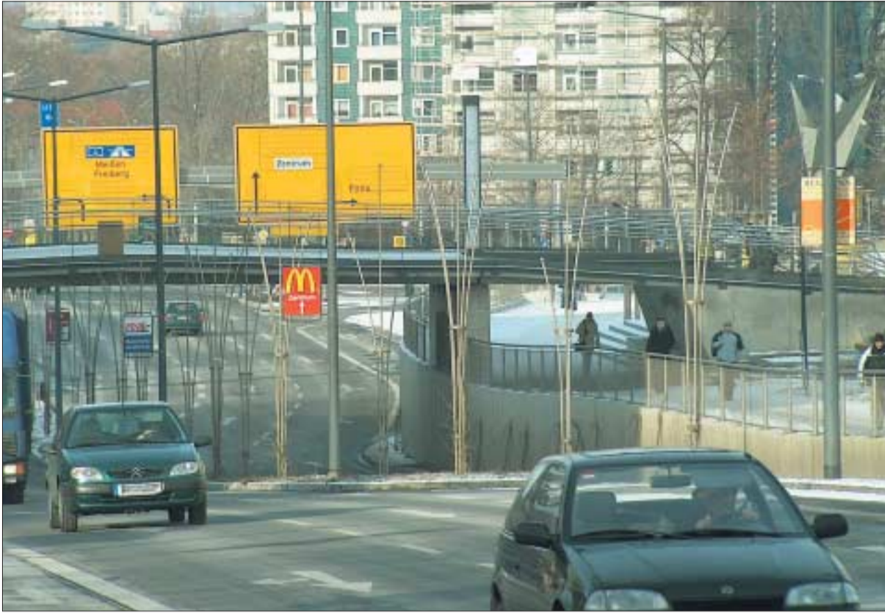
Der Ausbau der Bergstraße und die Eröffnung der A17 erbrachten eine Senkung der CO 2 -Emission um über 20 Prozent.
