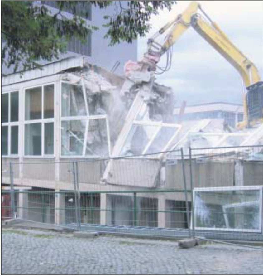
Das »Mausoleum« an der Bergstraße fällt.
