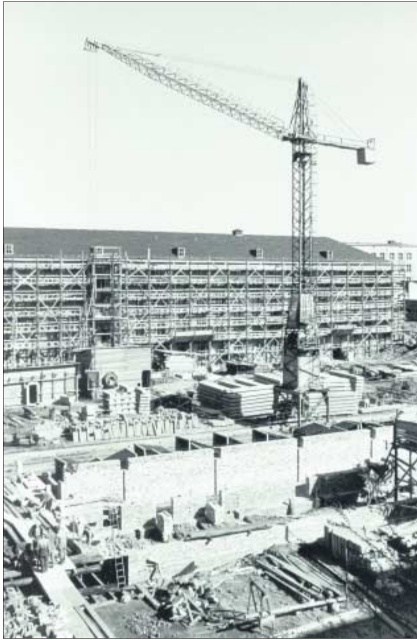
Baustelle des Barkhausen-Baus im Jahr 1957.
