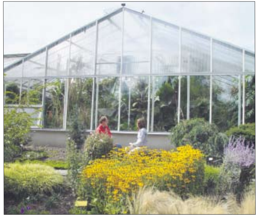
Neben zwei Seitenwänden und dem Dach wurde eine Giebelseite des großen Gewächshauses (Foto) erneuert. Foto: UJ/Eckold
