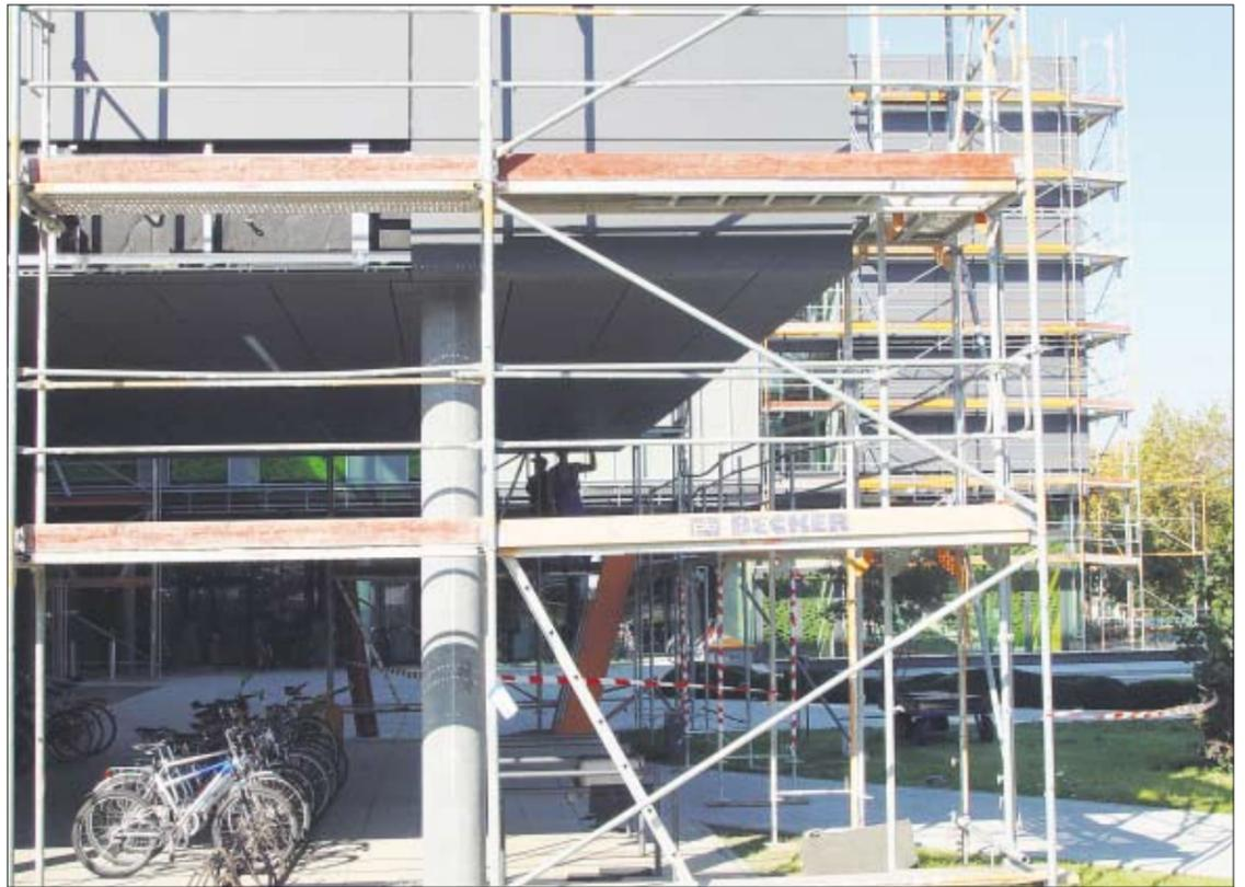
Viele Gerüste zeugen davon, dass derzeit am neuen Informatikgebäude Fassadenarbeiten im Gange sind. Zwei Jahre hängen die grauen Faserzementplatten an den Außenwänden und zeigen teils deutliche Mängel. »Die Platten »schüsseln«, erklärt Gerlinde Jacobasch, Objektverantwortliche im Staatsbetrieb Sächsisches Immobilien- und Baumanagement, »Sie wölben sich in den Randbereichen nach außen und sind da-
