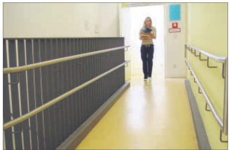
Eine Treppe im Erdgeschoss wurde durch diese behindertengerechte Rampe ersetzt. Das gelbe Linoleum wird bei falscher Pflege recht glatt.
