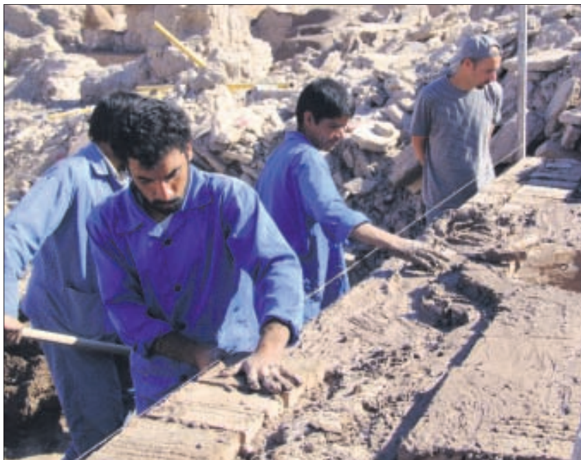
Eine iranische Mauerkolonnen stellt das Mauerwerk des zu restaurierenden Sistani-Hauses wieder her. Es soll durch den Einsatz palmfaserbewehrter Lehmsteine und durch Glasfaserstäbe erdbebenresistenter werden. Foto: A. Sobhan Sarbandi
