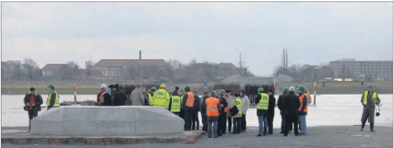
Bereits am Vormittag des 9. März 2009 besichtigten Referenten und weitere Symposiumsteilnehmer unter Leitung von Oberbauleiter Hans-Joachim Kummert (Firma Bit) die Baustelle der Waldschlösschenbrücke. Foto: UJ/Geise
