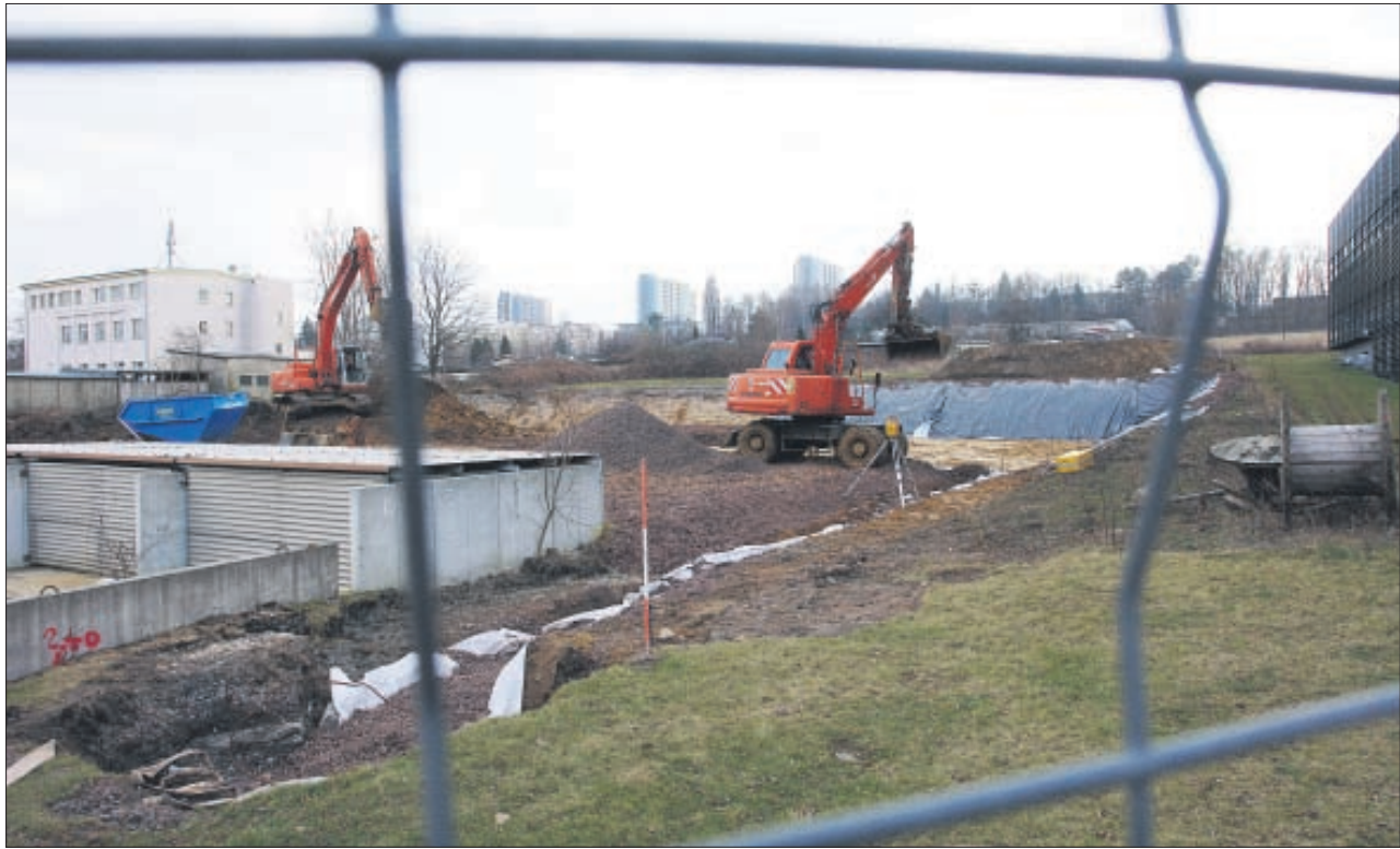
Neben dem Gebäude der Biologischen Institute (r.) sind derzeit Bauarbeiten im Gange.
