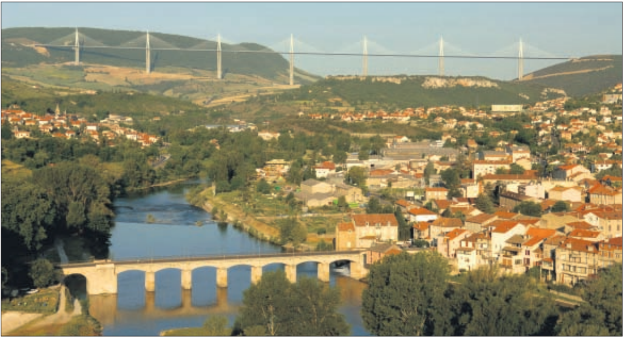
Der Viaduc de Millau (Hintergrund) überspannt das Tarn-Tal in Südfrankreich. Foto:Compagnie Eiffage du Viaduc de Millau G&D
