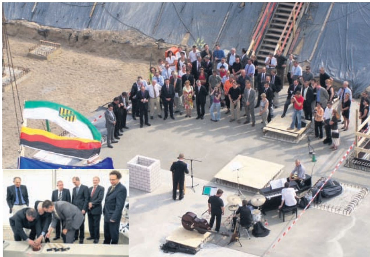
Gleich zwei Grundsteinlegungen gab es in der Semesterpause. In der Nähe des Uniklinikums entsteht der Neubau für das CRTD (großes Foto) und an der Hans-Grundig-Straße wird das Press- und Extrusionszentrum errichtet (kleines Foto). Fotos: CRTD/Kaßner; MZ/Liebert
