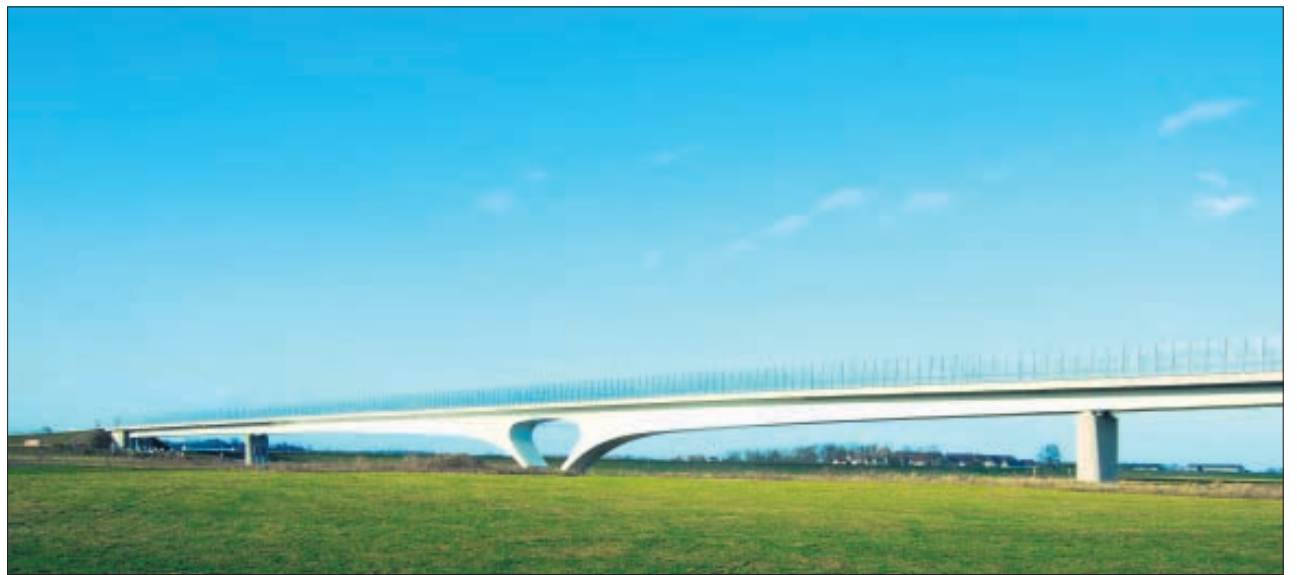
Den Brückenbaupreis 2010 in der Kategorie Straßen- und Eisenbahnbrücken erhielt die Elbebrücke Mühlberg. Foto:Archiv UvS
