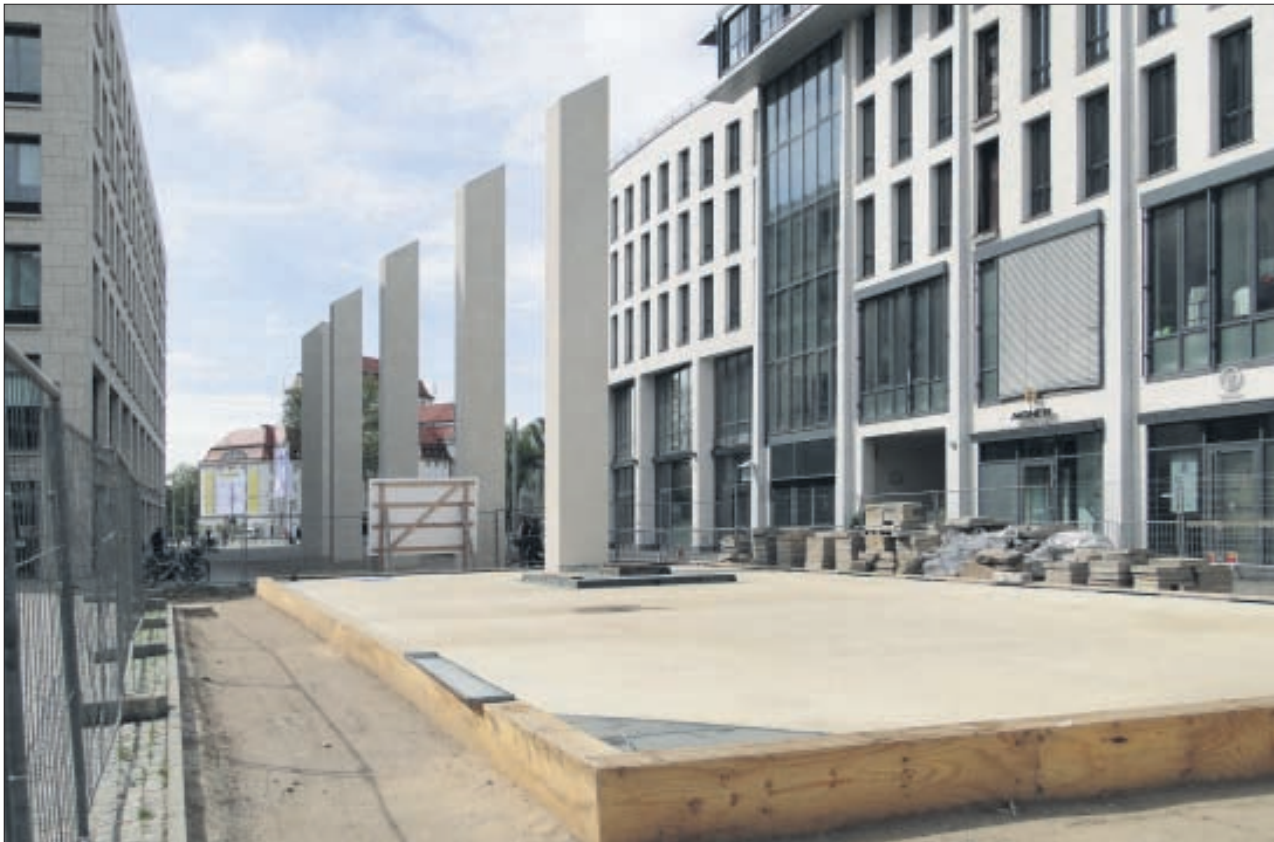
Die Gedenkstätte Busmannkapelle – hier Bauzustand 2010 – soll 2011 komplett übergeben werden.
