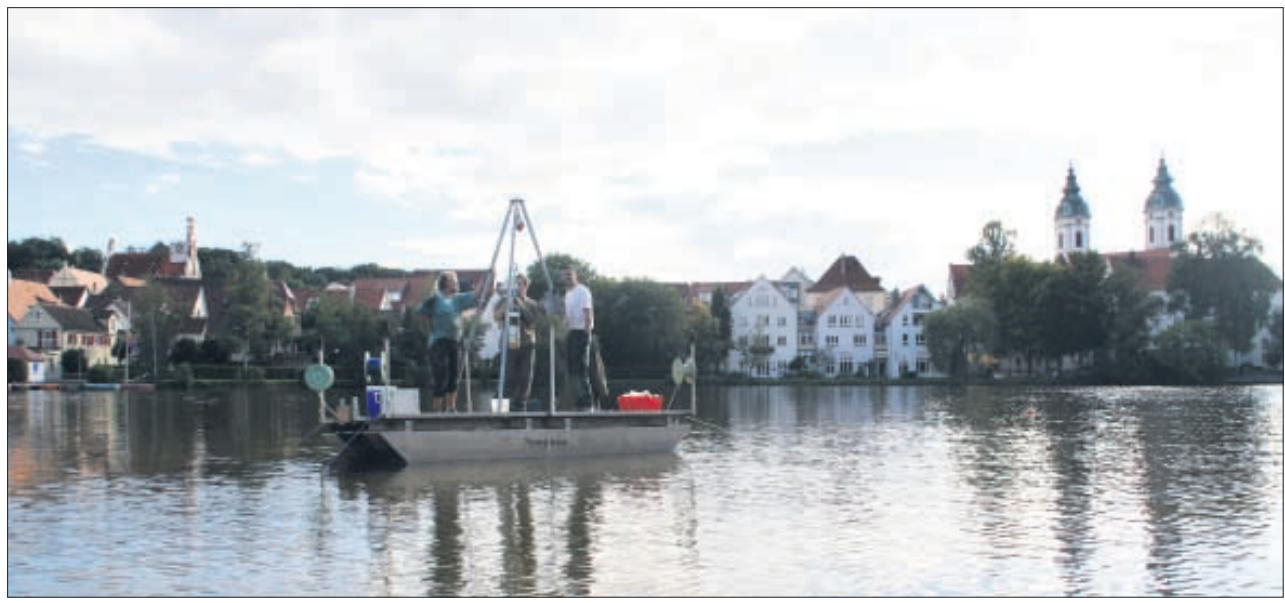
Schwimmende Arbeitsplattform mit der Bohrvorrichtung im Einsatz.
