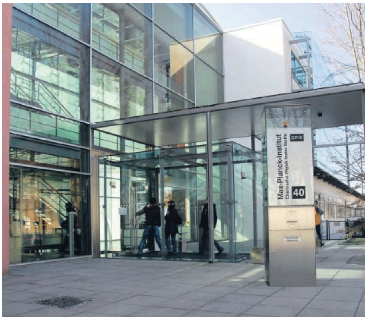
Haupteingang des Institutsgebäudes.
