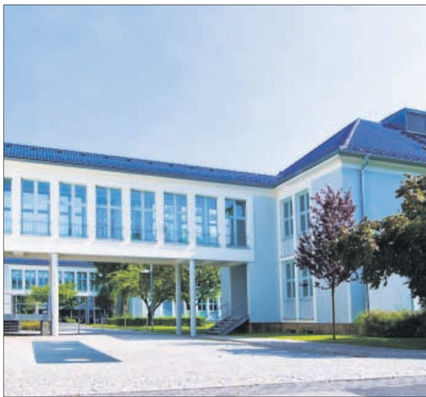
Das Fraunhofer-Institut für Elektronen- und Plasmatechnik Dresden an der Winterbergstraße. Foto:FEP
