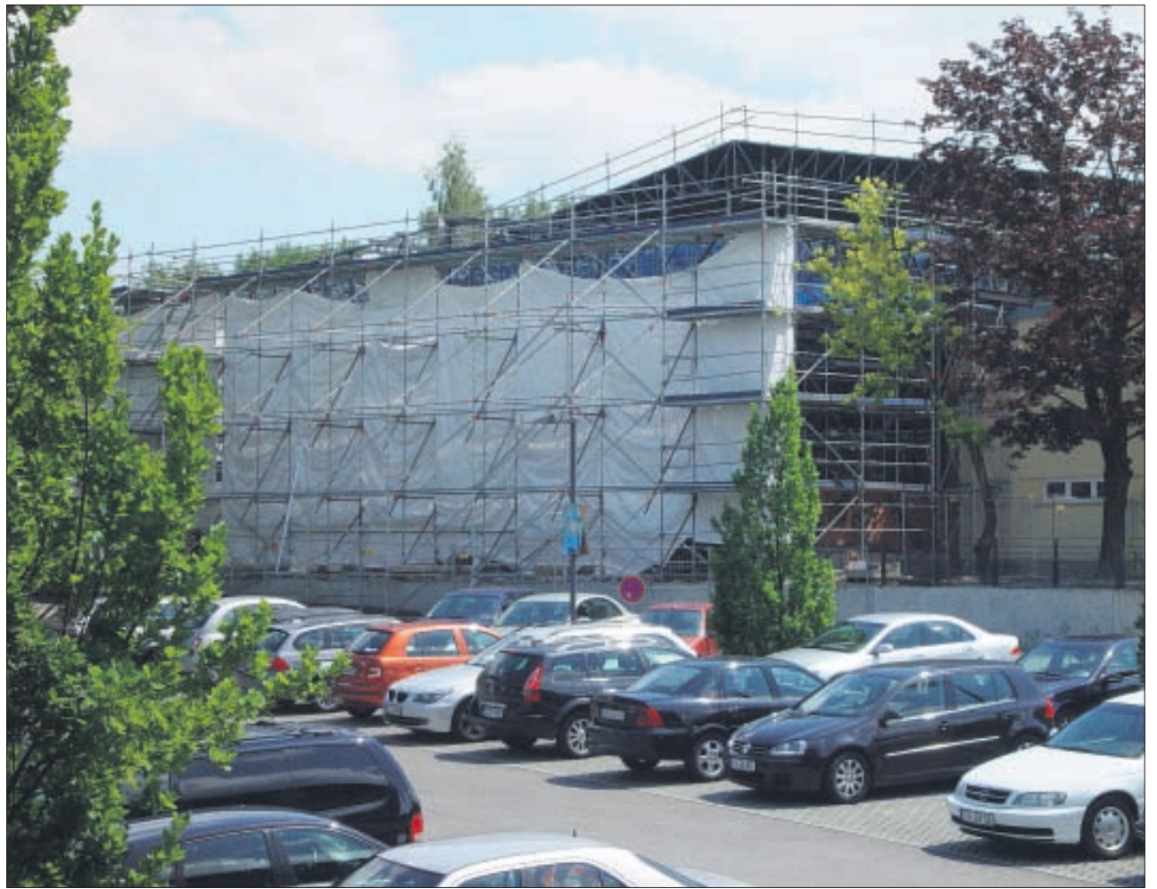
Die Halle II im Sportkomplex an der Nöthnitzer Straße wird derzeit komplett saniert.
