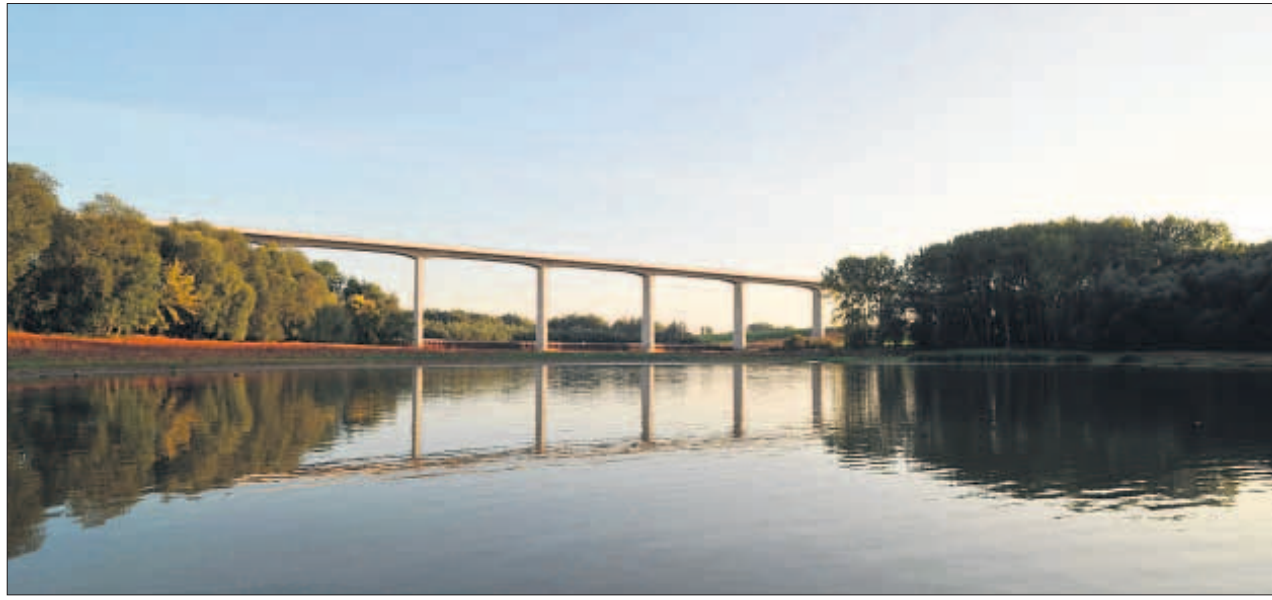
Die Scherkondetalbrücke erhielt den 1. Preis in der Kategorie »Straßen- und Eisenbahnbrücken«.
