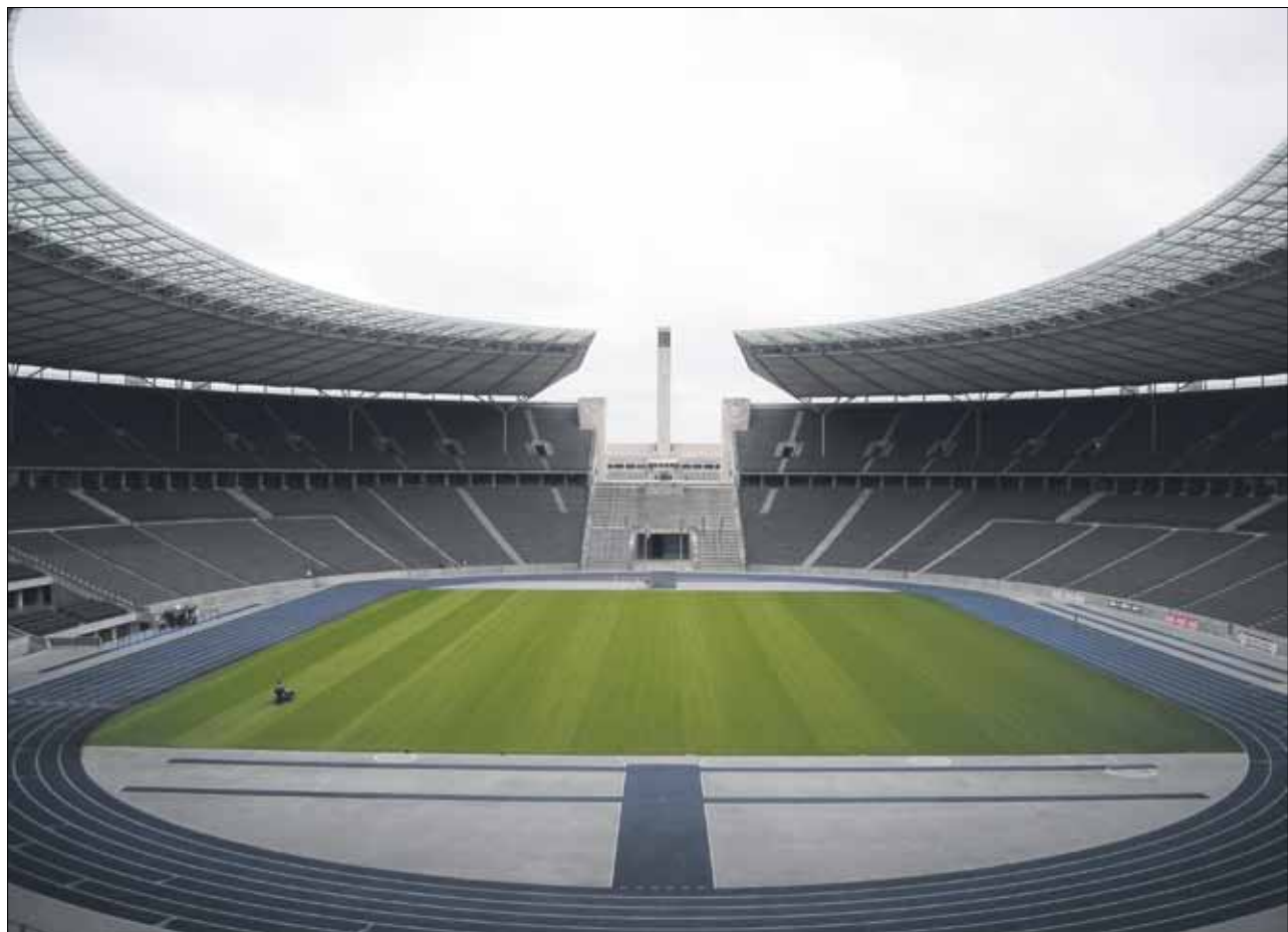
Das Berliner Olympiastadion wurde zwar vor rund einhundert Jahren erbaut, gilt aber auch heute noch als gutes Beispiel für einen großen Sportbau, der auch später vielfältig genutzt wird. Foto: Michael Barera/Wikipedia
