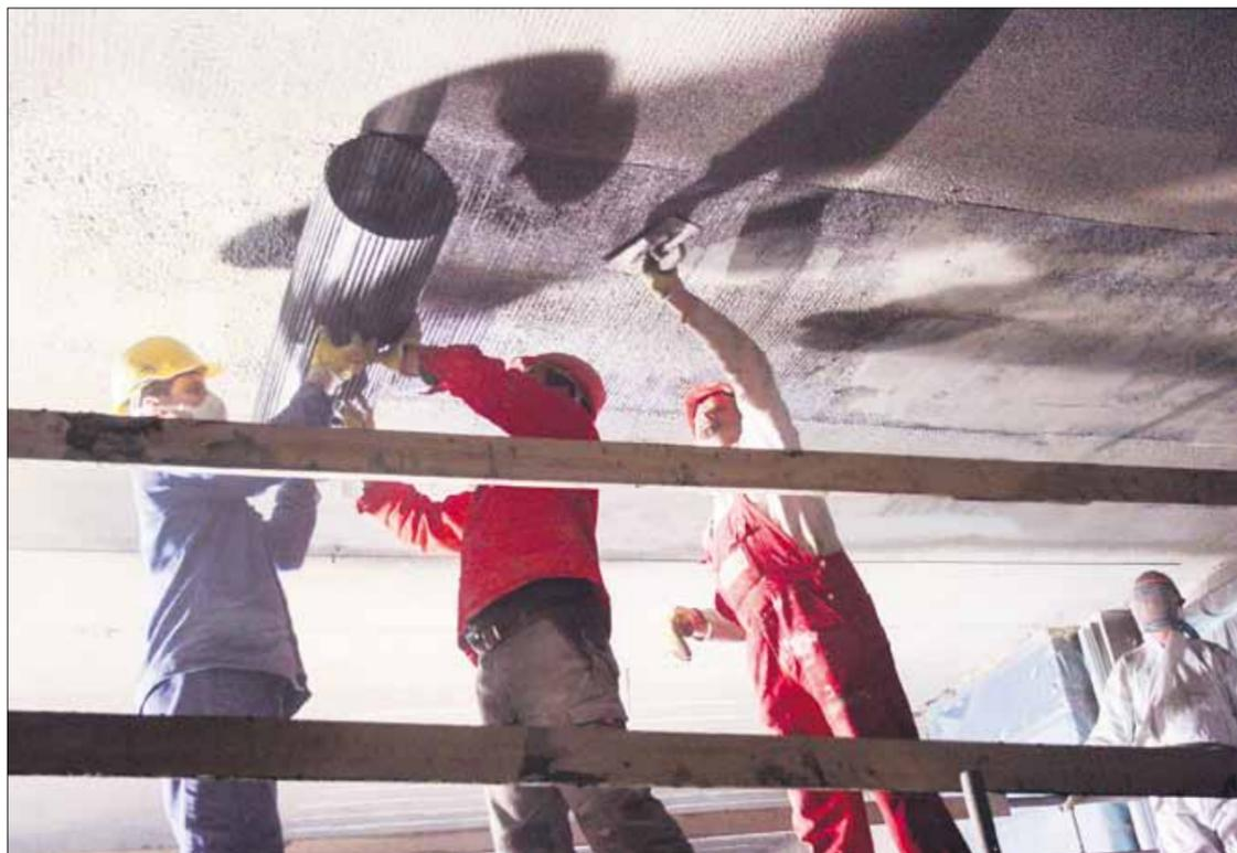
Sanierung einer Betondecke mit Textilbeton. Im Bild wird eine Textilbahn in das frische Betonbett eingebracht. Foto: Schladitz
