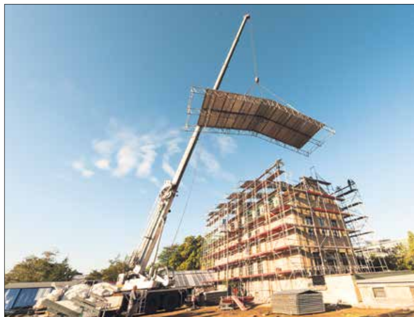
Aufsetzen eines Wetterschutzdaches für die Sanierung des ehemaligen Direktoriiumsgebäudes. Foto:UJ/Geise
