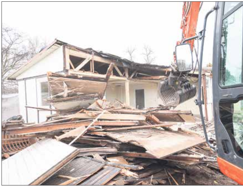
Mit schwerem Spezialgerät ging es der alten Sozialbaracke an das morsche Holz. Hier noch ein letzter Blick in den alten Pausenraum. Foto: UJ/Geise
