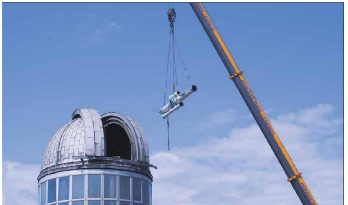
31. Mai 2016, Beyer-Bau: Der Refraktor wird aus der Kuppel des Lohrmann-Observatoriums gehoben.
