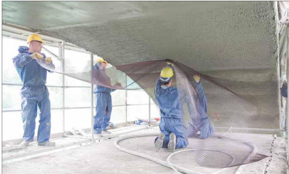
Carbonbeton eignet sich auch hervorragend dafür, bestehende Bauwerke zu verstärken. Seit 2006 wird das entsprechende Verfahren bei alten Bauten angewandt. Im Foto wird mit dem Verbundbaustoff eine Brücke im oberfränkischen Naila saniert. Foto: Jörg Singer
