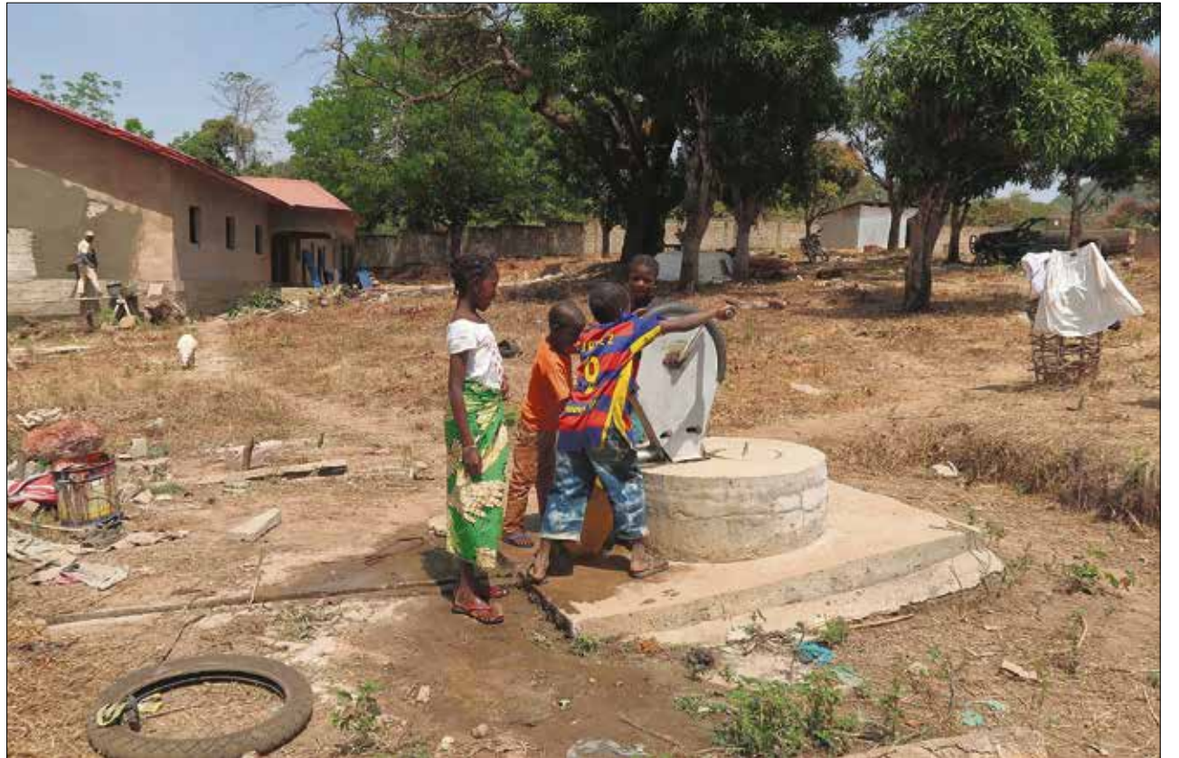
Kinder am Brunnen vor der Schulbaustelle in Télimélé. Bald wird es hier eine moderne Sanitäreanlage geben.
