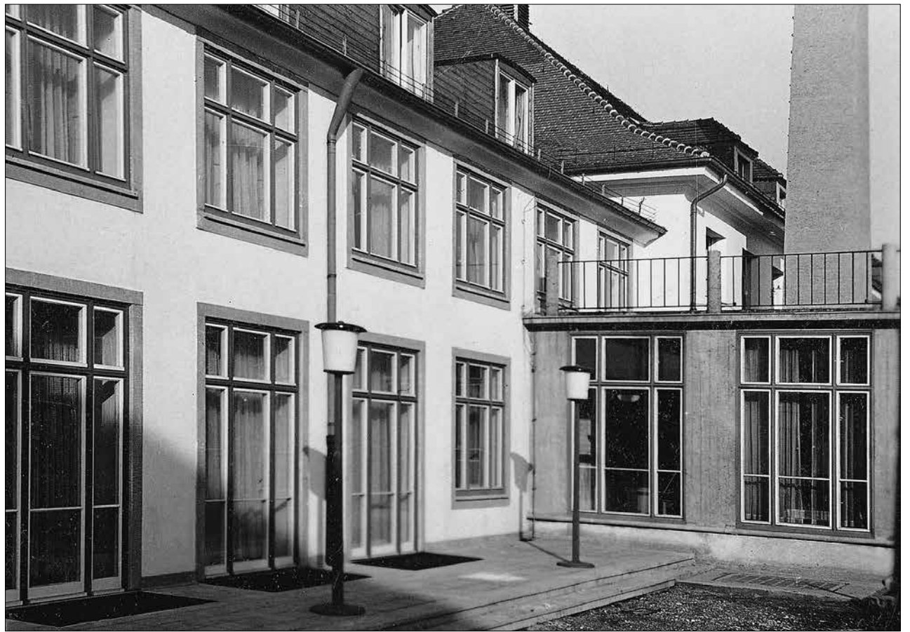
Karl Wilhelm Ochs: Die sechsteilige Fenstergestaltung mit den Kunststeingewänden (»Ochs-Fenster« – hier Detail der Mensa-Erweiterung). Fotos (2): Stiftung Sächsischer Architekten, Privatnachlass Karl Wilhelm Ochs
