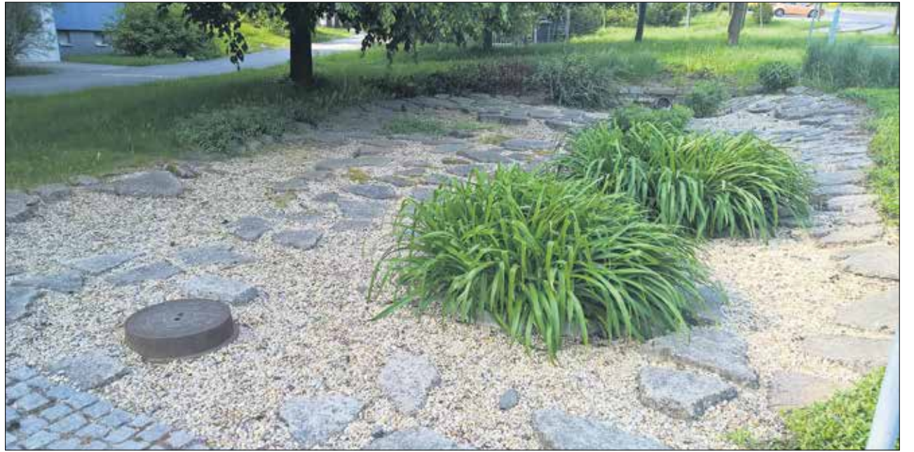
Ein Beispiel, wie Kommunen Überflutungen durch Starkregen begegnen können: Die Eisenbahner-Wohnungsgenossenschaft (EWG) hat Rückhaltegräben für Regenwasser in der Kräutersiedlung (Dresden-Gorbitz) angelegt. Das Regenwasser wird in den Mulden zwischen- gespeichert, wo es nach und nach versickert sowie verdunstet. Die Bepflanzung hat gestalterische Gründe. Foto: Majana Heidenreich
