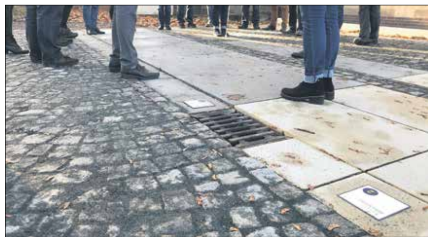
Begebar: die Musterfläche zwischen Binder- und Fritz-Foerster-Bau. Foto: Katrin Klunker
