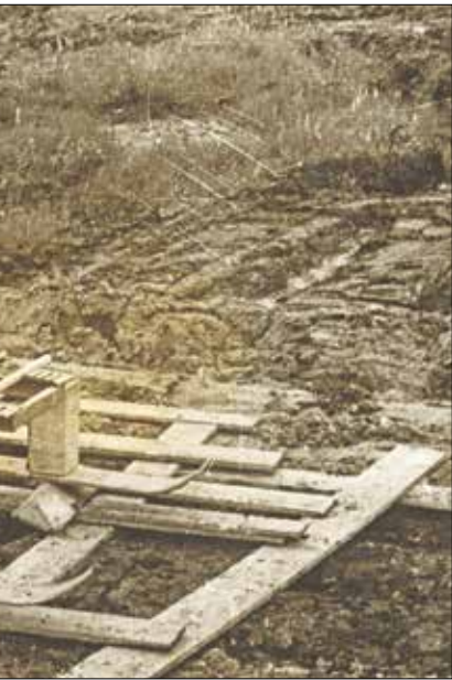
Einsinkversuche für Panzerketten an der damaligen TH Dresden. (Quelle: Nachlass Eberan von Eberhorst, R., Berichte und Untersuchungen, 1943–1944, v. Nr. 04, 2. Bericht Spezifischer Bodendruck u. Einsinktiefen, Institut für Kraftfahrwesen der Technischen Hochschule Dresden, 22. November 1943, Trittplatten-Meßgerät mit Beton-Zusatzgewichten.)
