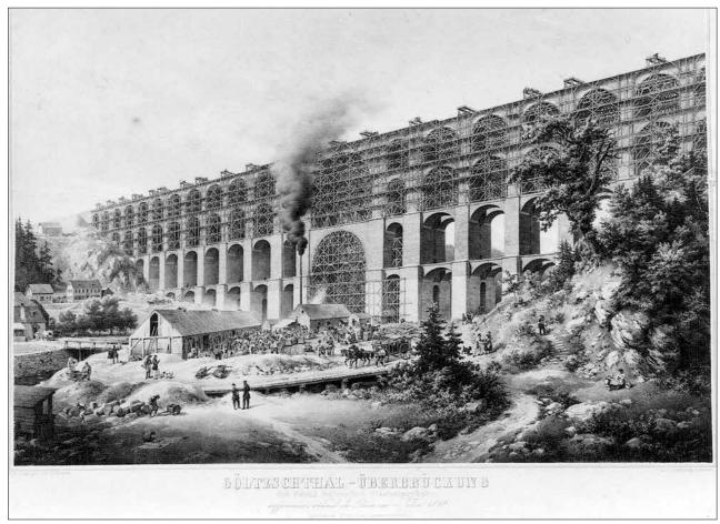
Die Lithografie von Friedrich Wilhelm Baessler zeigt die Göltzschtalbrücke, für die Schubert die Konstruktionsunterlagen erstellte. Die größte Steinbogenbrücke der Welt wurde von 1846 bis 1851 aus 26 Millionen Ziegeln erbaut.
