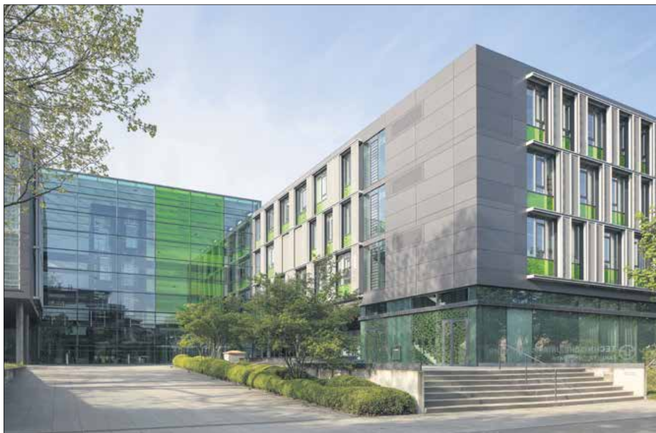
Der Andreas-Pfitzmann-Bau an der Nöthnitzer Straße.
