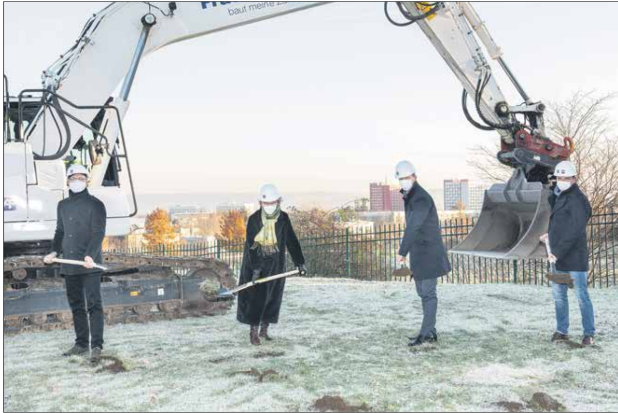
Beim traditionellen ersten Spatenstich: Architekt Stephan Schultze (Blum & Schultze Architekten), Rektorin Prof. Ursula M. Staudinger, Kanzler Dr. Andreas Handschuh und Jochen Gerards, Geschäftsführer des Bauunternehmens Frauenrath (v.l.n.r.). Foto: TUD/Kretzschmar
