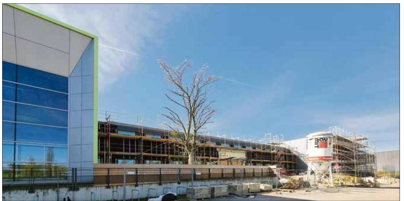
Nach Abschluss der Bauarbeiten tobt hier bald wieder das pralle Sportleben von Badminton über Geräteturnen bis hin zum Boxen.
