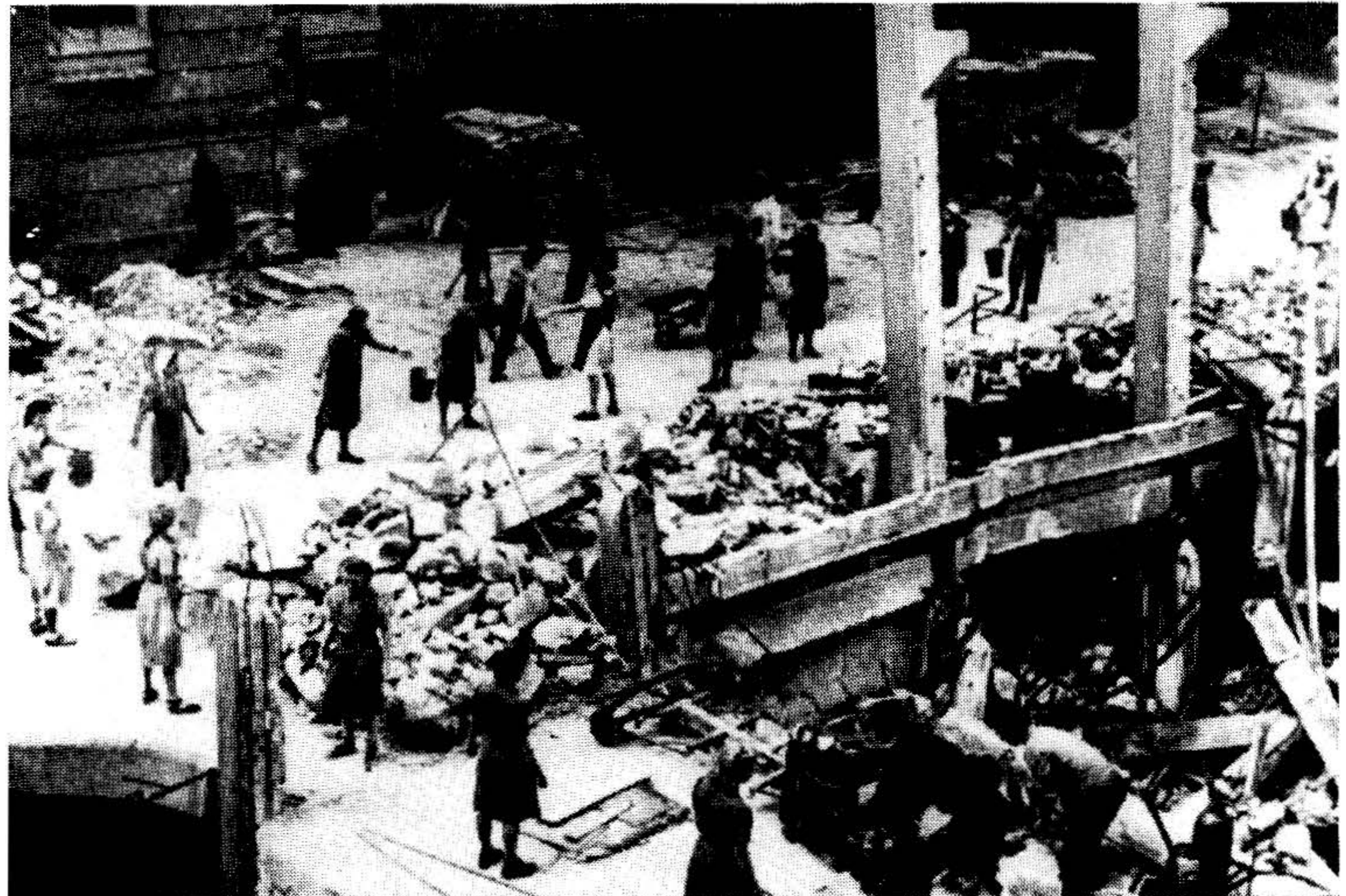
Mitarbeiter der „Technischen Lehr- anstalten“ bei Entrümmerungs- arbeiten
