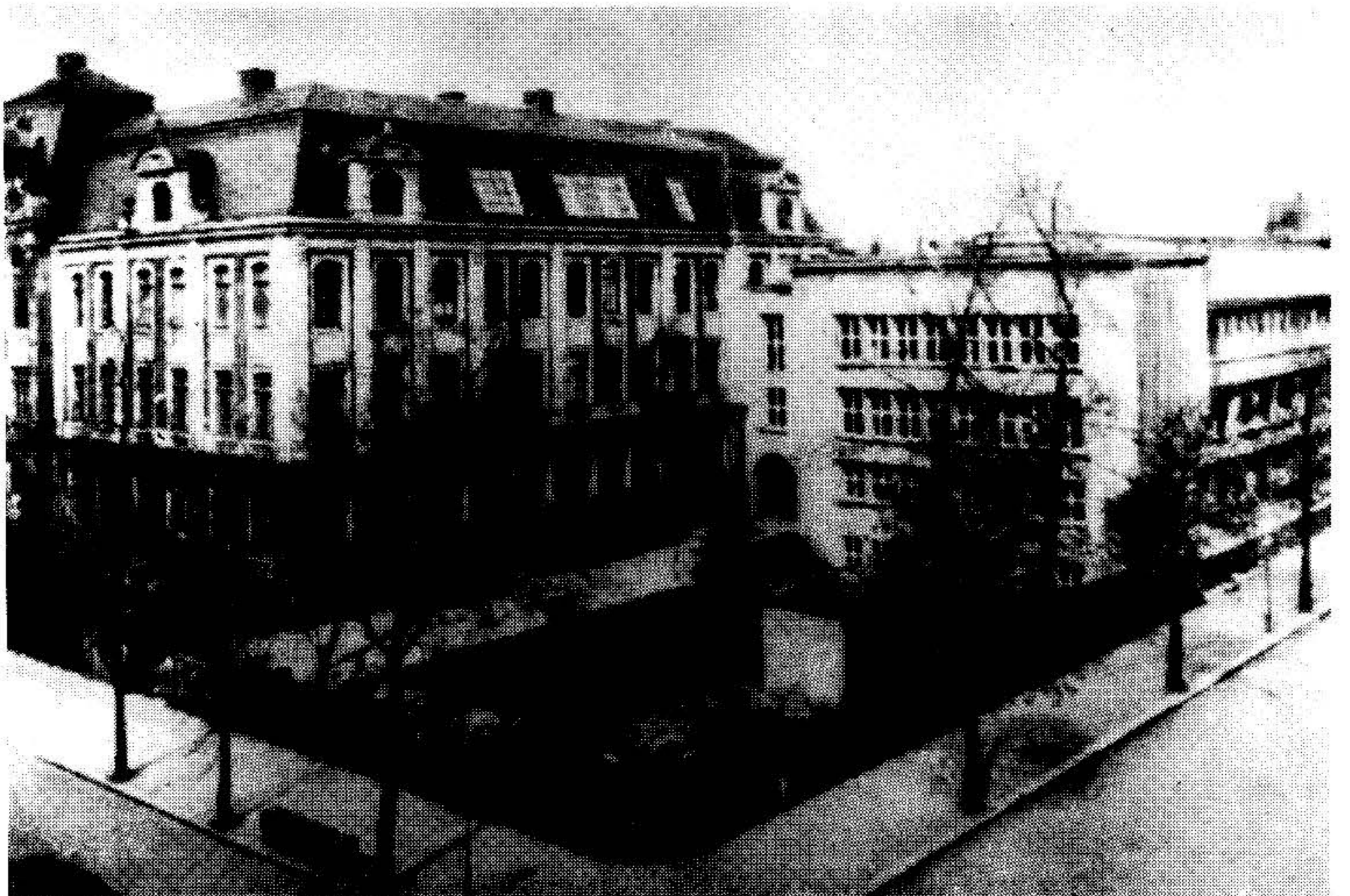
Gesamtansicht der „Technischen Lehr- anstalten der Stadt Dresden“ vor der Zerstörung durch anglo-amerikanische Bomber am 13. Februar 1945
