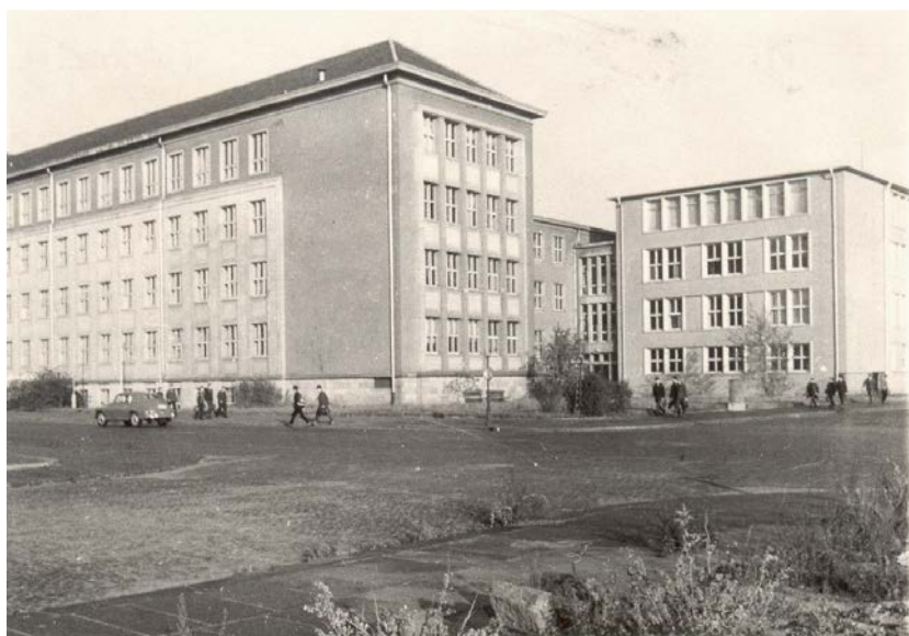
Abbildung 16 Neubaufügel Dürerstraße mit Teil des Altbaus Elisenstraße 25 nach der Aufstockung
