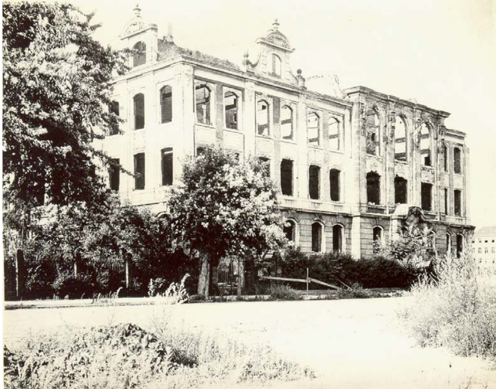
Abbildung 15 Ruine des Schulgebäudes Dürerstraße 45
