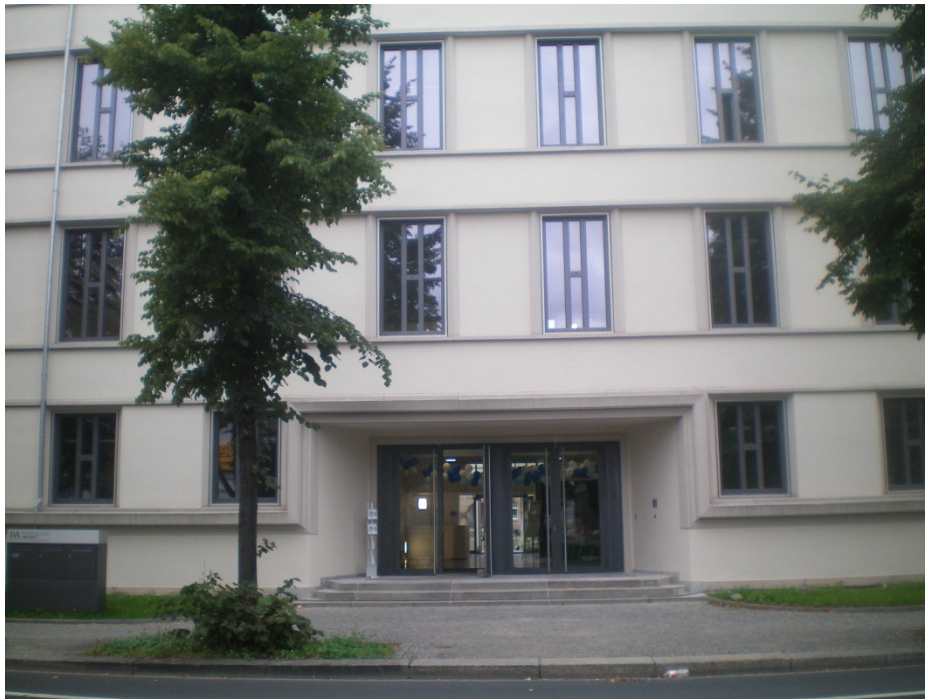
Abbildung 17 Eingang zum Schulgebäude August 2011
