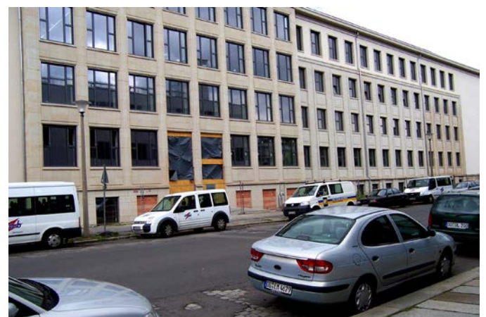
Erweiterungsbau 1958 an der Dürerstraße nach Rekonstruktion 2011
