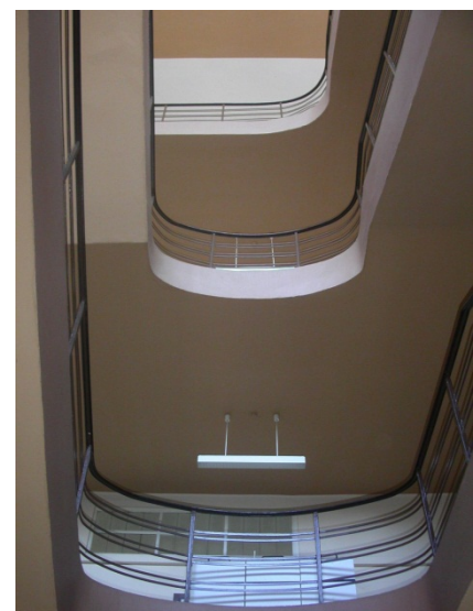
Aufnahme Treppenaufgang vom 07.09.2006
